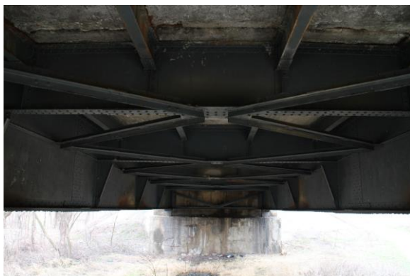
a. Structura de rezistență a podului Șcheia
