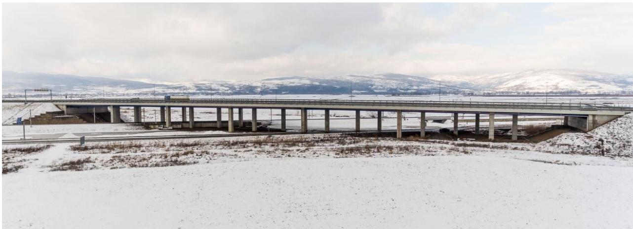
Figura 13 – Viaduct peste CF și DN7 pe sectorul Orăștie-Sibiu, L=240 m
