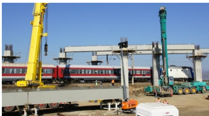
Figura 14 – Faza de construcție sub trafic feroviar
