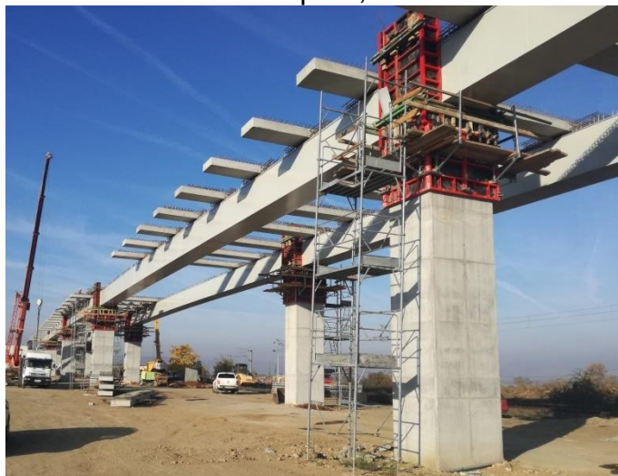
Figura 15– Dispunere antretoaze pe grinzile metalice
