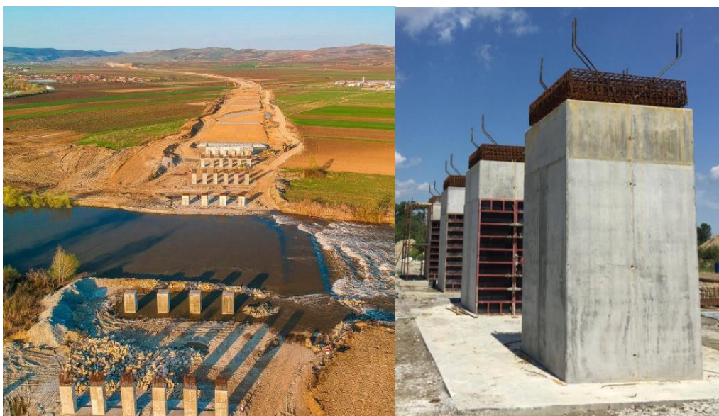
Figura 8 – Infrastructuri km 34+750 (stânga) și detaliu pile cu articulații (dreapta)
