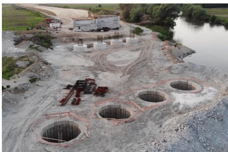
Figura 10 – Stadiu actual infrastructură axe 20, 30, 40
