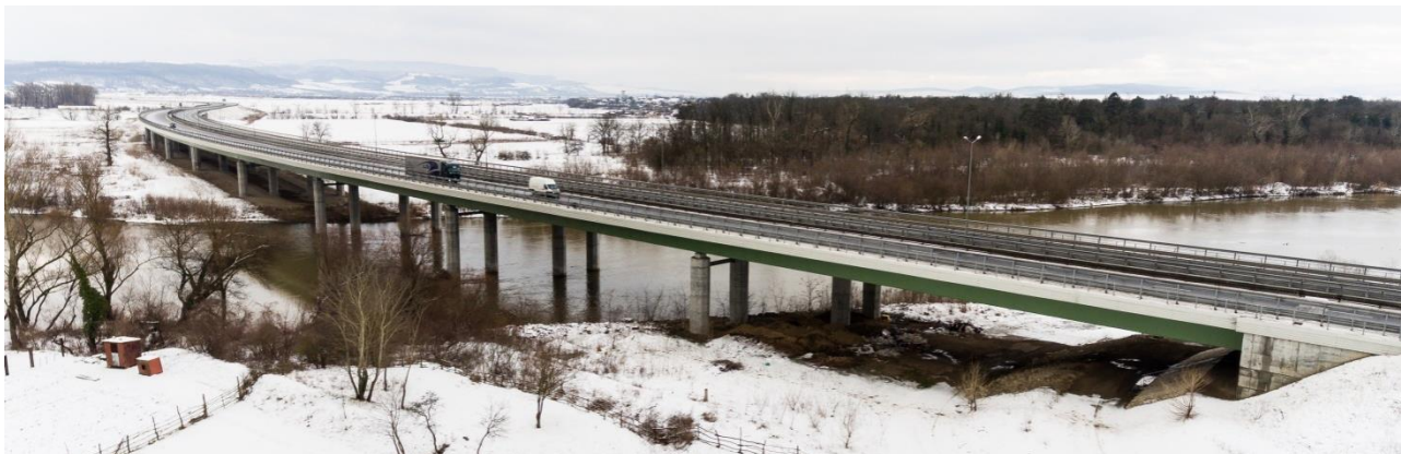
Figura 11– Pod peste Mureș, L=720 m
